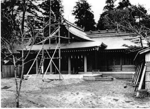
造営中の旧寒川神社拝殿（昭和 2 年頃）
