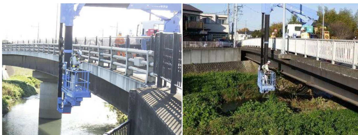
橋りょうの点検状況
