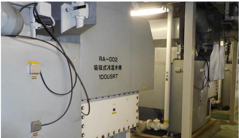
吸収式冷温水発生機
