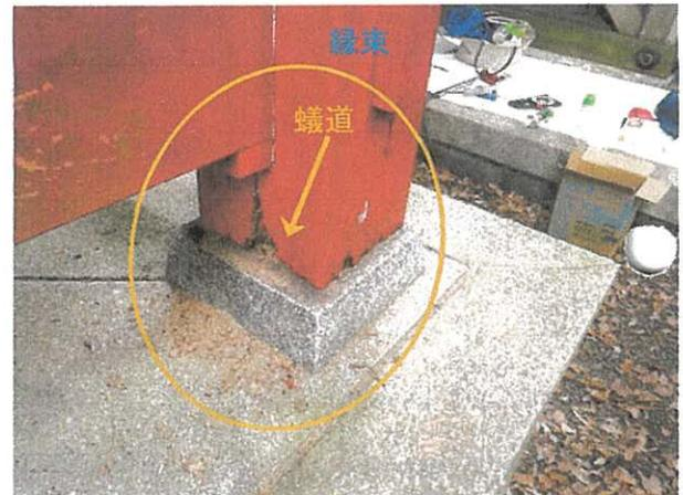
6.南西面 浜縁縁束 腐朽(虫害)状況
