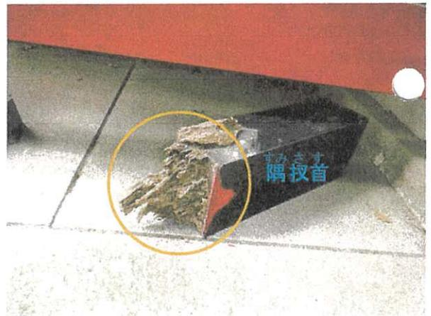
4.南西面 浜縁隅扱首 腐朽(虫害)状況
