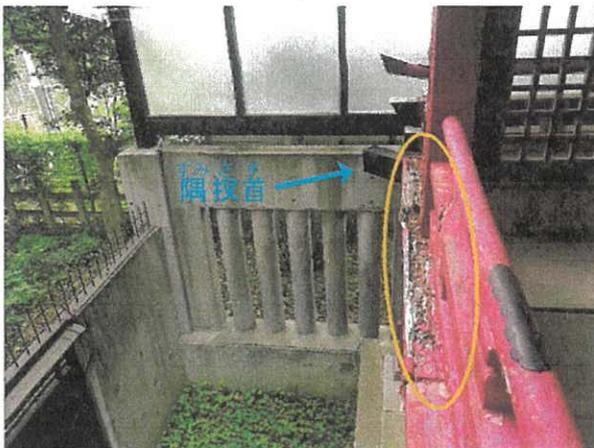
5.北西面 高欄・浜縁腐朽状況
