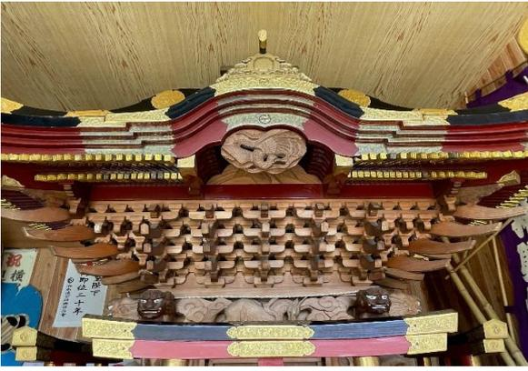
現在の状況・修理内容:神輿枡組ですが、歪み・損傷が激しく、使用するのに支障をきたしている。
