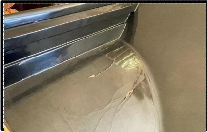
現在の状況・修理内容: 神輿屋根ですが、経年劣化に伴い、ひび割れ 剥がれが激しく、使用するのに支障をきたしている。
