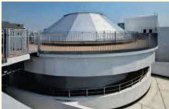
幅広い年代に利用されている文化センターのプラネタリウム (品川区立第一日野小学校)
