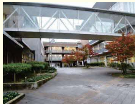
学校（左側）、市立体育館（右側）共用のアプローチ
