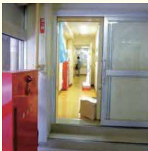
保育所部分は床を上げて水回りを 整備。避難時に使える扉も設置
