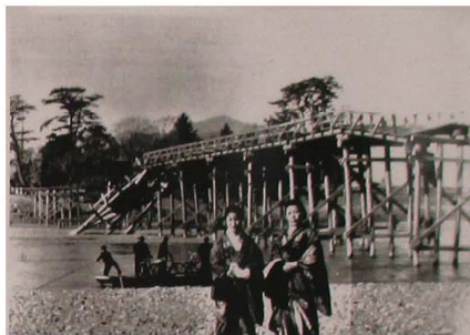
神川橋 昭和13年に一之宮と田村間に初めて架かった（昭和16年撮影 大水で崩落した様子が見える）。
