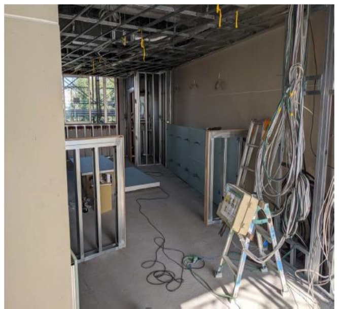
2F 内装、造作工事
