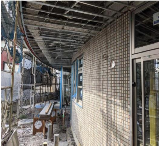
外壁タイル張り
