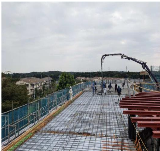
RF（3F）コンクリート打設
