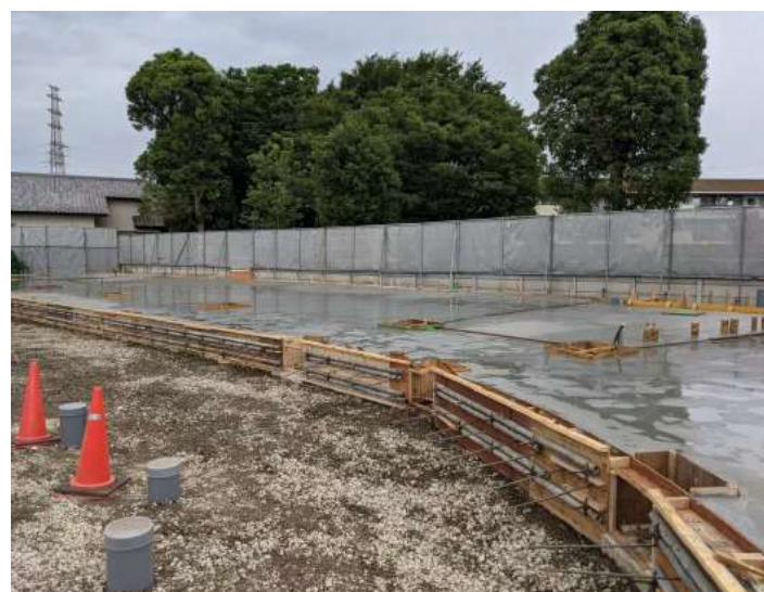
1Fスラブコンクリート打設完了 6月末までの状況
