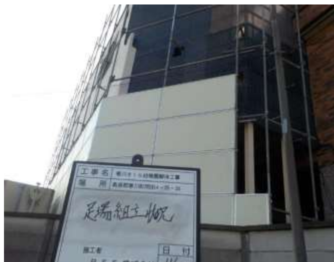
ホー儿棟 足場状況
