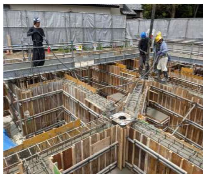
基礎コンクリート打設
