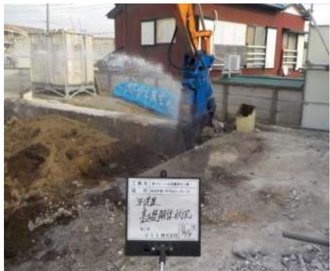
3F 建屋基礎解体
