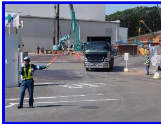
工事車両 誘導状況
