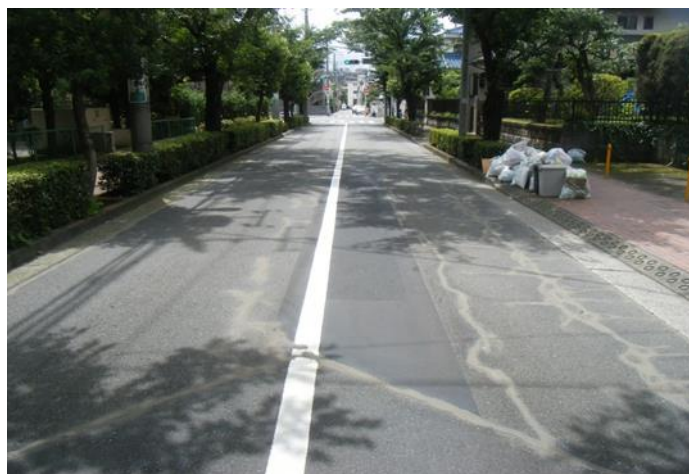
図8 クラックシール工法の例
