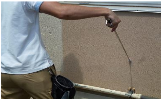
①器具を使用して外壁を叩き、劣化の進行を確認する様子
