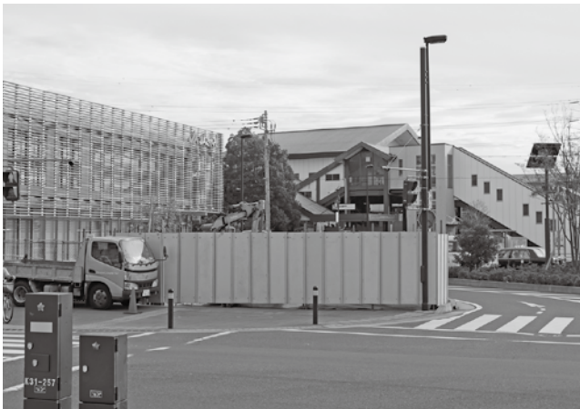
着々と工事が進む 寒川駅前（北口） 交番建設現場（写真中央）と JA さがみ（写真左側）
