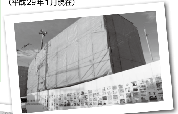
工事中の寒川駅南口自転車等駐車場 (平成29年1月現在)
