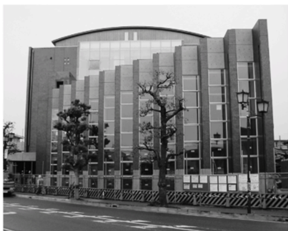
囲いがはずれ、その全容を現した総合図書館
