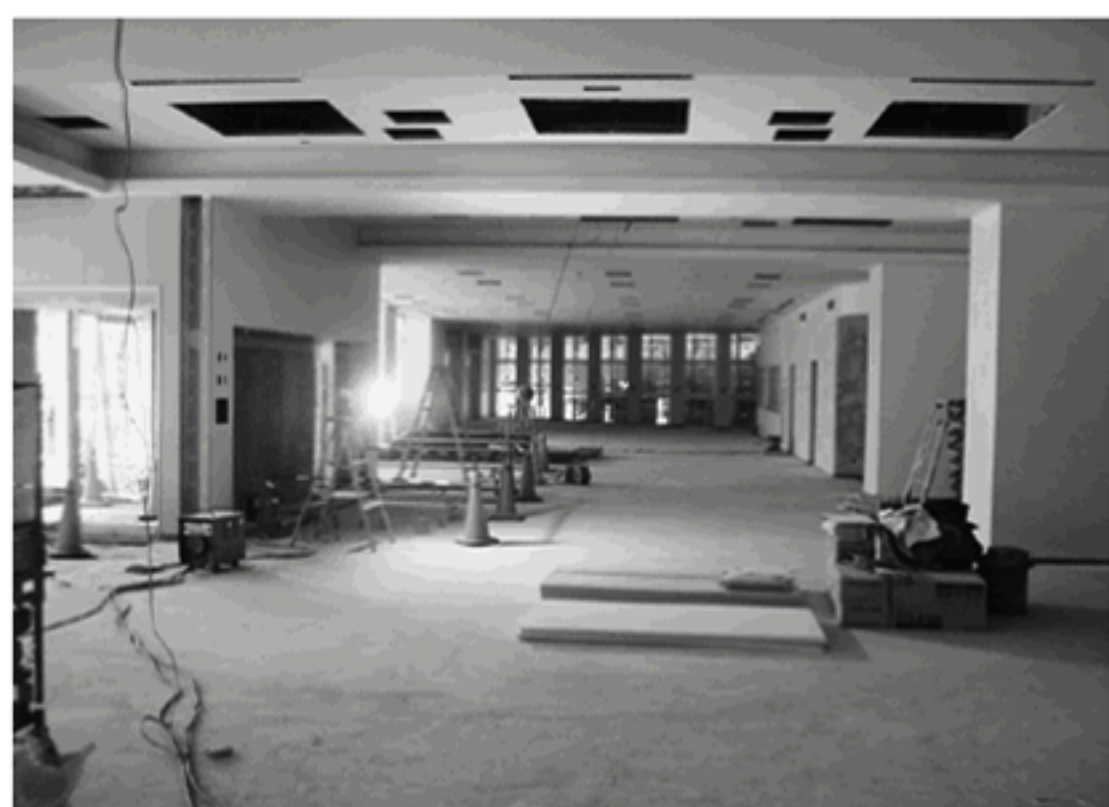
内装工が進む館内（1階中央付近）
