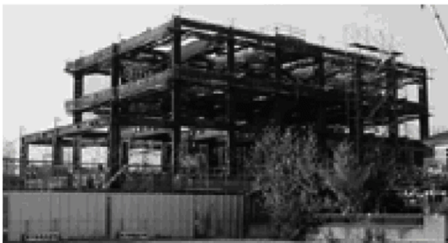
現場 四階まで骨組工事が進んだ建築工事
