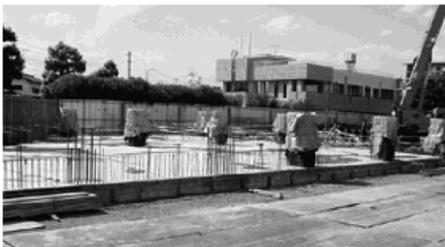
地下工事の完了した図書館
