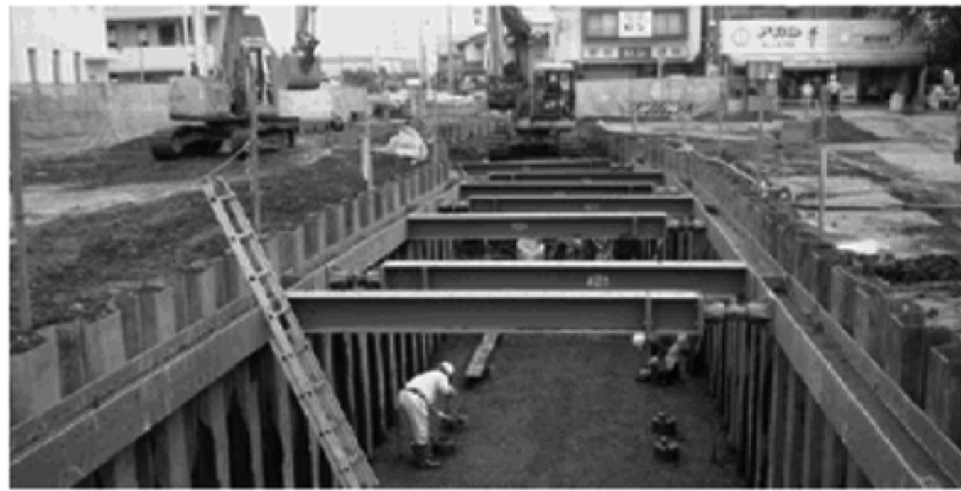
新堀雨水幹線の整備工事（ＪＡさがみ寒川支店北側）
