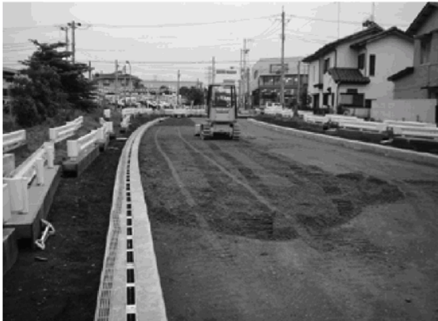
整備の進む都市計画道路寒川下寺尾線（岡田交差点西側）
