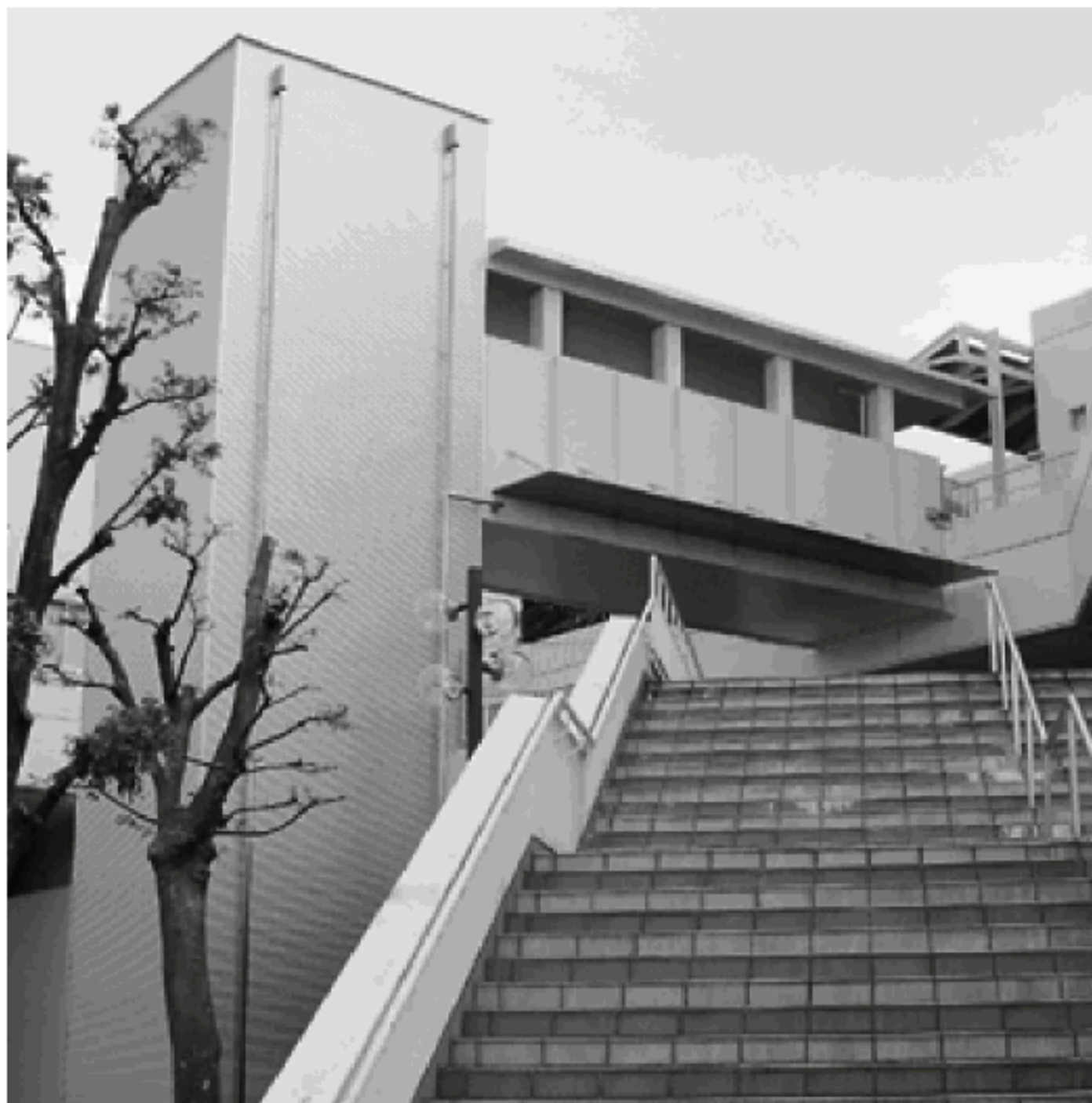
町民センターのエレベーター
