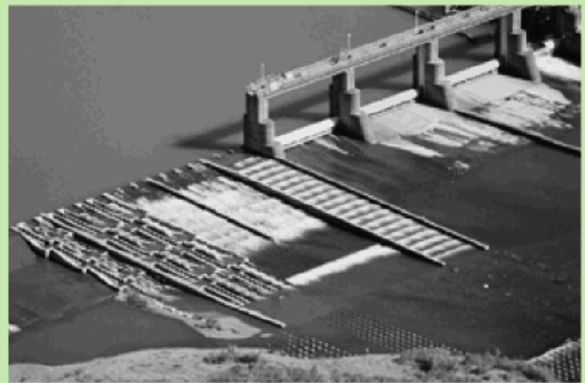
左がデニール式魚道、右が階段式魚道
