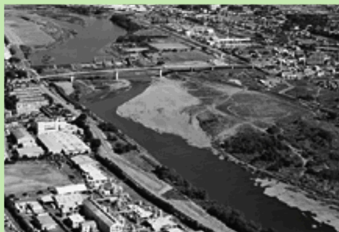
寒川取水堰と神川橋付近の相模川
