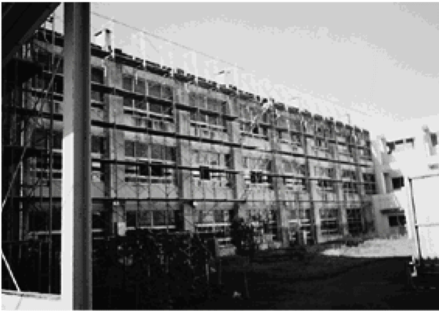
小学校施設改修事業（寒川小学校）
