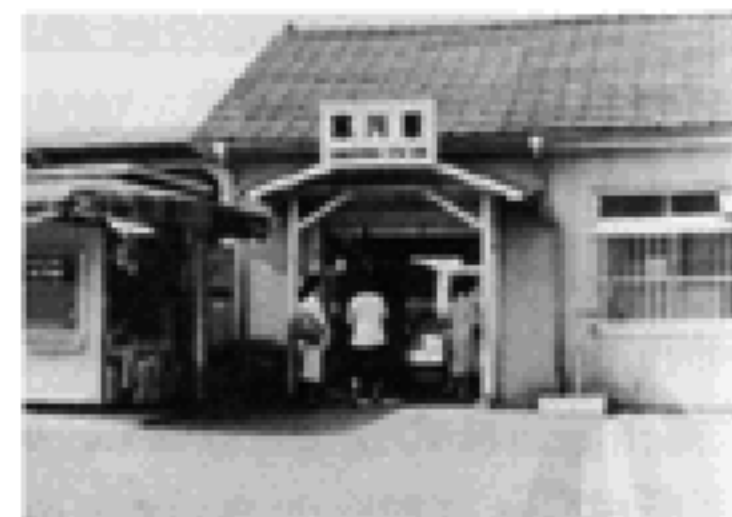
寒川駅旧駅舎(昭和66年)〔ナ-17〕
