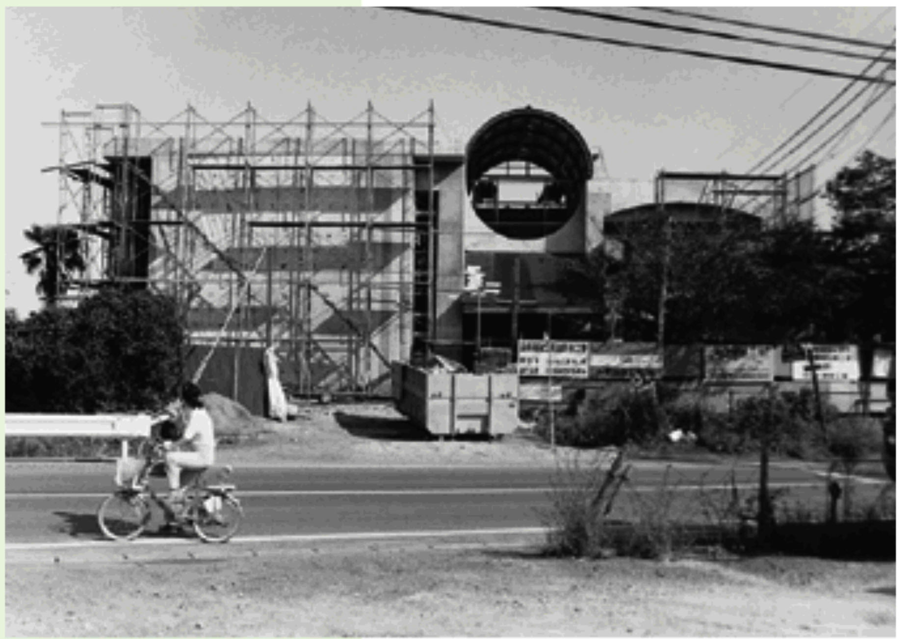
建設中の北部文化福祉会館（昭和五十六年）
