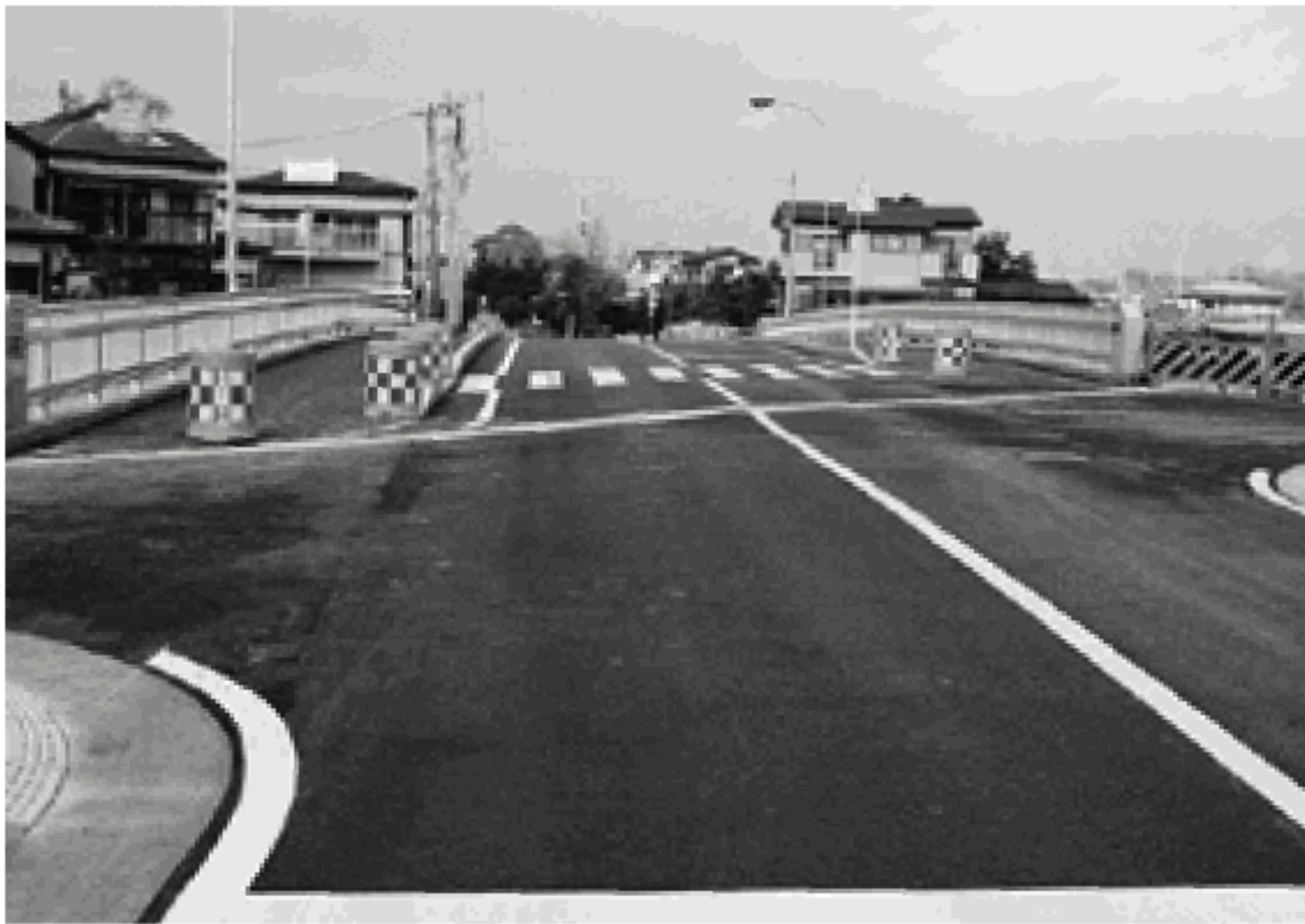
橋りょう架替事業（寒川橋付近）
