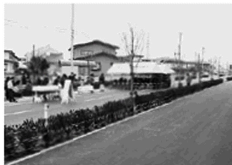
開通した都市計画道路山西米沢線。手前の歩道の広さが特徴的です。
