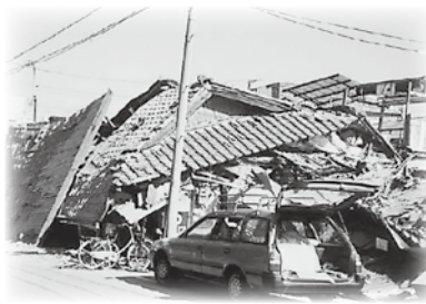
阪神淡路大震災で倒壊した家屋(災害写真データベースより)
