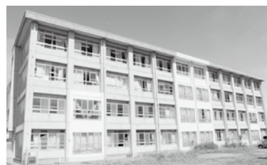
耐震補強工事後の 町立小谷小学校
