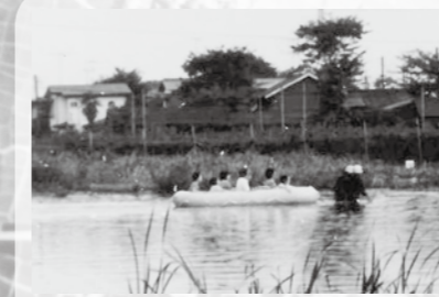
台風の被害 昭和51年の台風17号は目久尻川を氾濫させるなど町に大きな被害をもたらした。
