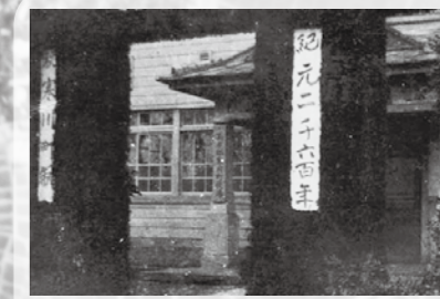
町制施行当時の町役場 町制施行は、戦時色が強まるなか、神武天皇即位2600年記念に合わせて実施された。
