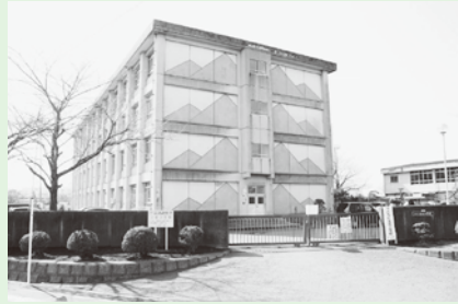
小谷小学校教室棟、旭が丘中学校技術棟耐震補強工事を実施
