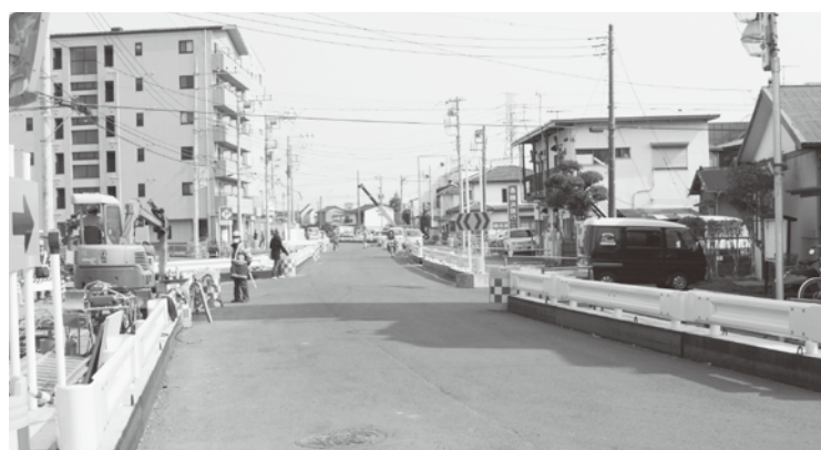
工事が進む寒川下寺尾線（3月13日撮影）
