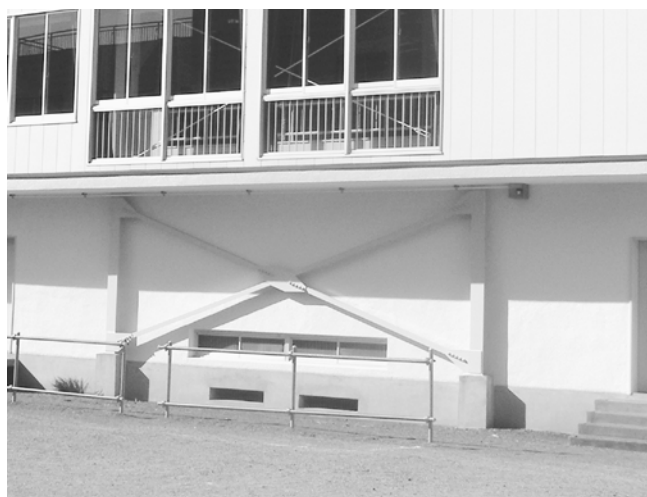
鋼製の筋交いで補強された寒川小学校体育館
