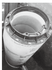
設置されたマンホール
