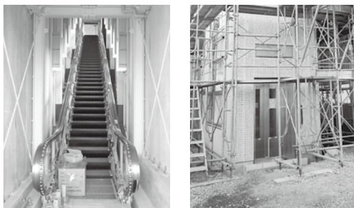
設置工事の様子
