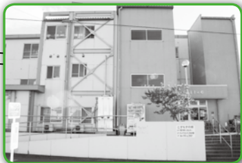
北側から見た外観
