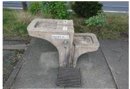
蛇口が壊れている水飲み場
