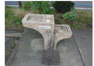
蛇口が壊れている水飲み場
