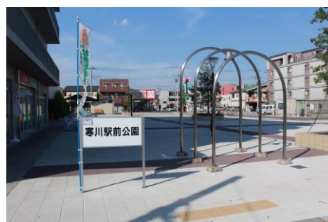
寒川駅前公園(平成 22 年)
