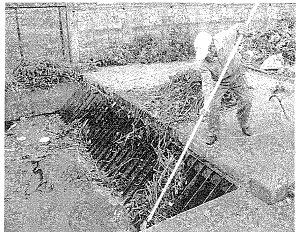
大蔵サイフォンの塵芥除去作業の様子
