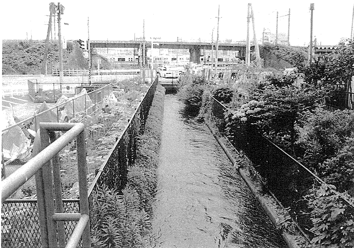
海老名市国分地内 海老名駅電車基地上流
