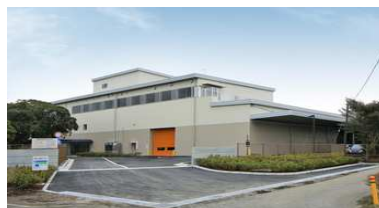
寒川広域リサイクルセンター
