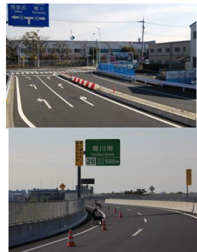
さがみ縦貫道路全線開通
