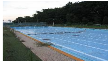
利用休止中の町営プール
