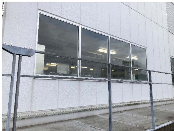
千葉県新港学校給食センター屋外見学窓
