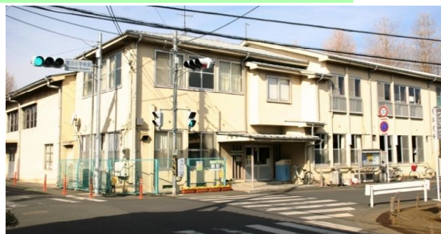
寒川町公民館(平成22年1月撮影)
