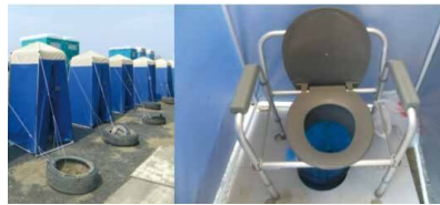
東日本大震災時に使用されたマンホールトイレ 出典：国土交通省ホームページより https://www.mlit.go.jp/mizukokudo/sewerage/mizukokudo_sewerage_tk_000411.html
