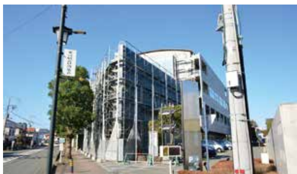
▲外壁タイル修繕を行っている寒川総合図書館
