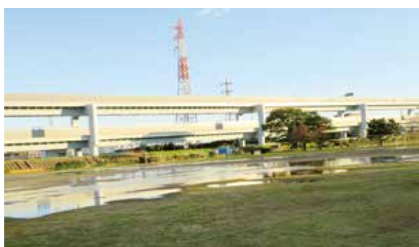
▲雨天後翌日の川とのふれあい公園サッカー場
