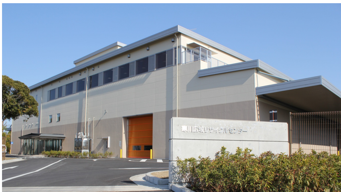
寒川広域リサイクルセンター (平成 24 年 3 月 25 日開所)
