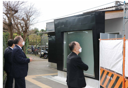
宮山駅舎トイレ
