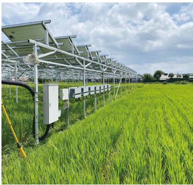
田んぼの上部に設置された太陽光発電のパネル(小田原市内)
